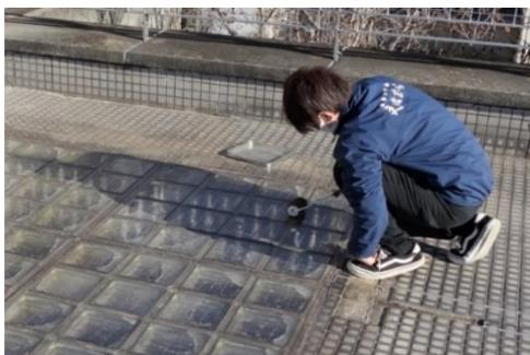
○コンクリートの亀裂からの雨漏り補修
